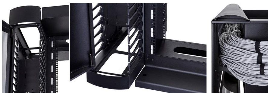
Entrada de cabos pelo guia vertical.
